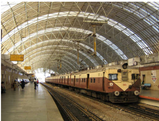
سازه های فضایی در یک ایستگاه قطار
